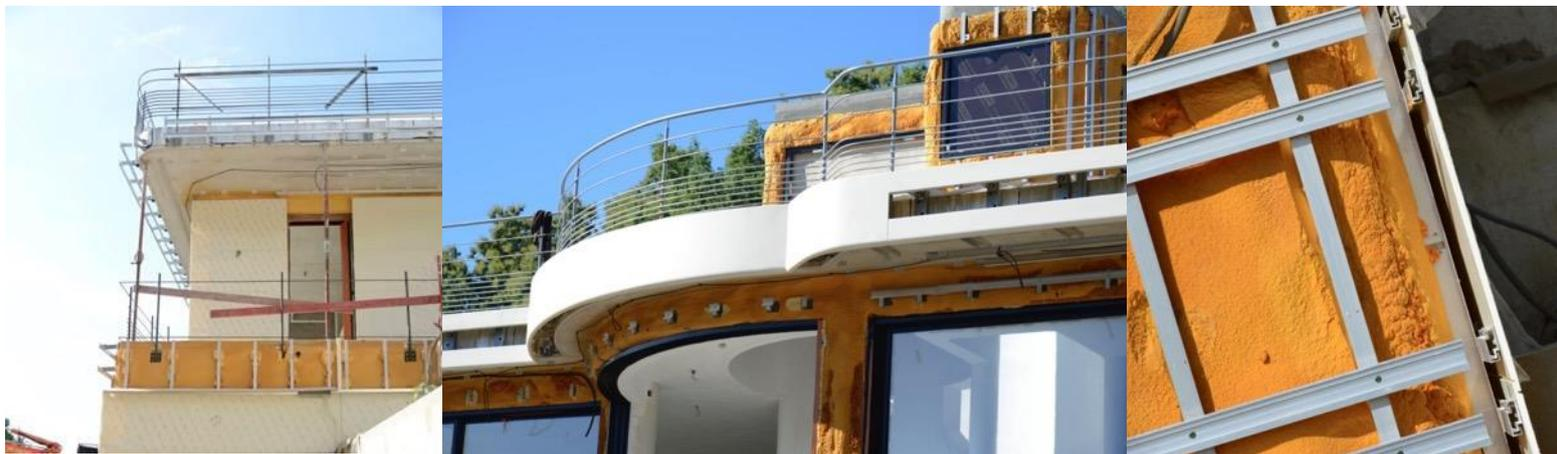
Con la sua superficie di 550 m2, la facciata ha un'ossatura in metallo posata su una muratura in cemento grezzo, ricoperta e isolata con schiuma poliuretanic. I 220 pannelli in **HI-MACS®** Cream, di spessore 12 mm, sono termoformati e si sposano perfettamente le curve della struttura, così come i suoi pilastri e gli oblò.
