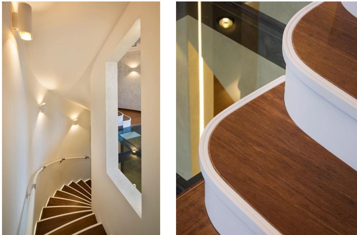
Realizzati da Menuiserie Bareau e SARL ACORRS, gli scalini della rampa interna sono in HI-MACS® unito a una base di pavimentazione in bambù incollato e modellato in loco. Il legno, associato alla purezza del materiale Solid Surface, ha conferito all'ambiente allo stesso tempo fluidità e calore.
