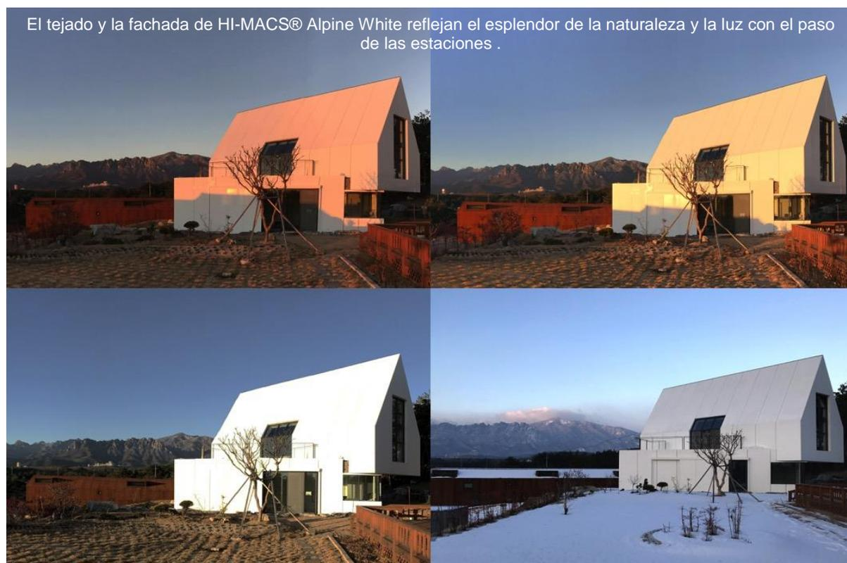
**Según Woojin Lim**, «La decisión de utilizar **HI-MACS®** para crear la fachada era obvia. Una de las principales causas de alteraciones en una fachada son las corrientes de agua de la lluvia. Con **HI-MACS®**, un ensamblaje perfecto proporciona una solución a las ranuras verticales de otros materiales que hacen que la estructura sea permeable y aceleran el deterioro de la fachada a lo largo del tiempo».
