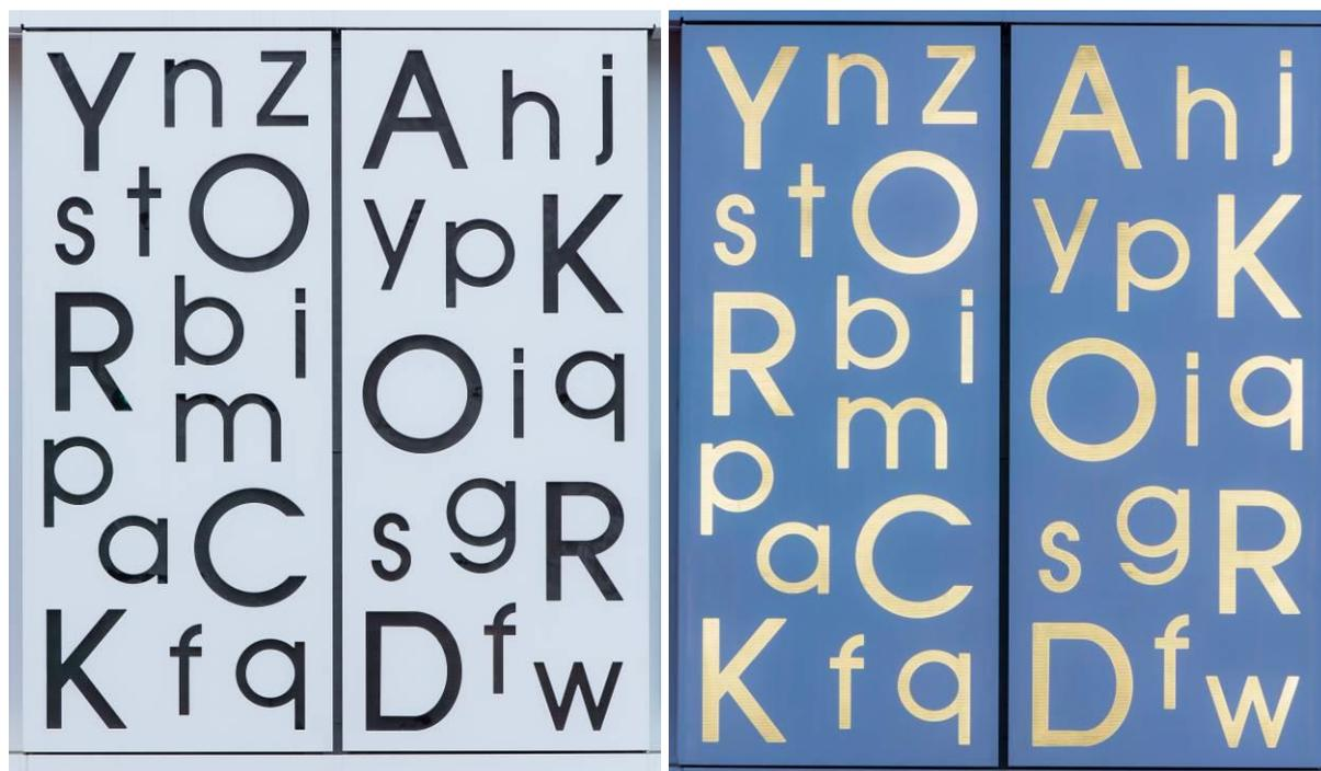
En cuanto al diseño arquitectónico de la fachada, las letras están fresadas en la superficie de HI-MACS®, a través de la tecnología CNC, y cada una de ellas tiene un diseño único. La estructura está retro-iluminada para permitir una mejor distribución de la luz y sus lados están ligeramente contorneados con una luz LED, para así suavizar las letras que componen los poemas.
