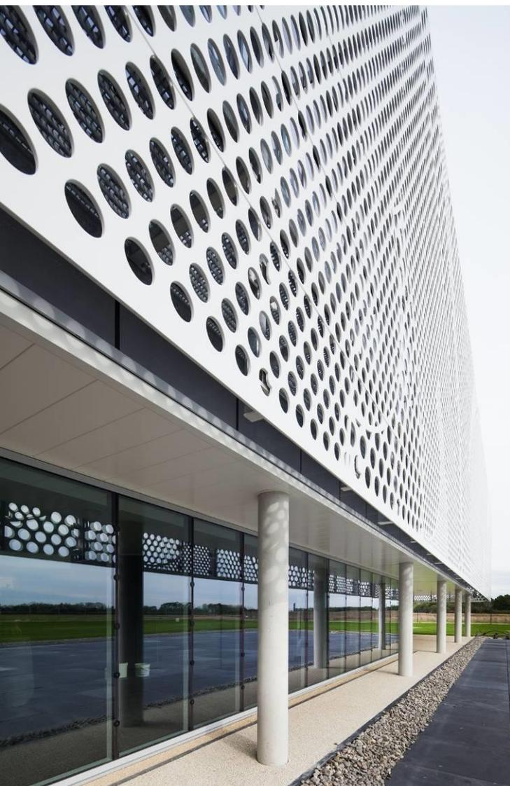
HI-MACS® crea un equilibrio entre la dimensión del proyecto y el sistema estructural. Además, los paneles han sido instalados y unidos a los postes de metal que hacen que la estructura de paneles parezca ligera y delicada. Para **el fabricante LCCA**, el principal obstáculo fue ocultar los métodos de sujeción y permitir al mismo tiempo la tensión mecánica relacionada con la exposición. HI-MACS® sabía cómo satisfacer las expectativas tanto del cliente como de los proveedores de servicios.
