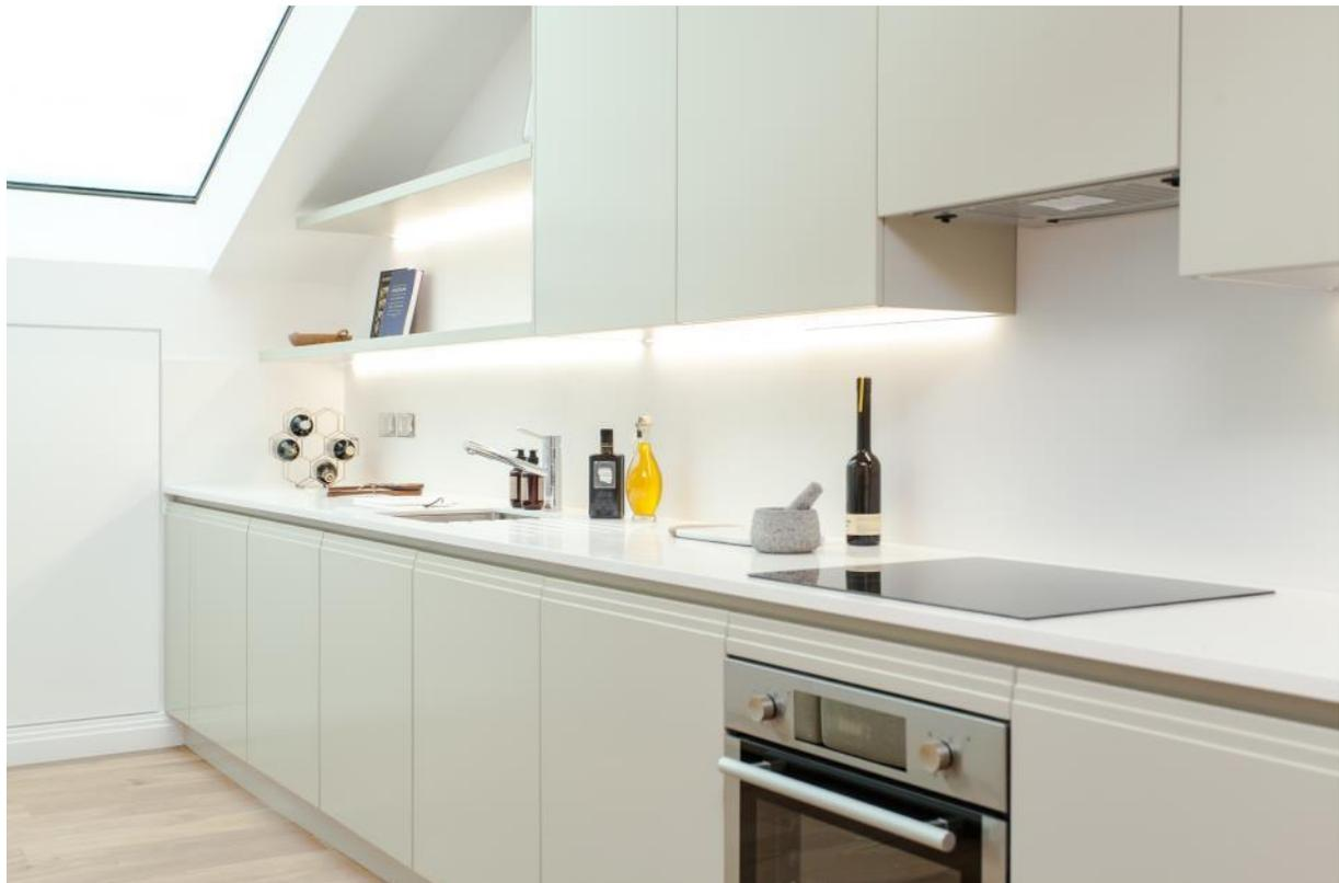
Neben der Eigenschaft, sich nahtlos aneinanderfügen zu können, so dass der Eindruck entsteht, die Oberflächen seien aus einem einzigen Materialstück gefertigt, waren weitere Gründe für die Wahl von **HI-MACS®** seine extreme Widerstandsfähigkeit und absolute Hygiene, die perfekt für den Umgang mit Lebensmitteln ist. Die porenfreie Oberfläche verhindert die Ansammlung von Ablagerungen oder Bakterien und erleichtert die Reinigung der Küchenoberfläche.
