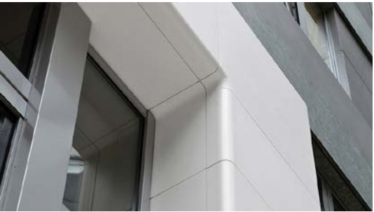
De belangrijkste eigenschap bij het gebruik van HIMACS op een gevel is de mogelijkheid om ronde hoeken te maken.
