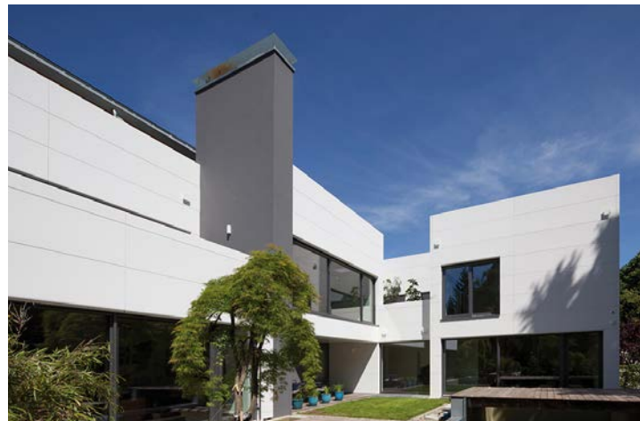
Architect: Dipl.-Ing. Volker Wiese, Berlin - Kaden Klingbeil Architekten | Uitvoering: Kiebitzberg GmbH & Co.KG -Kloepfer Surfaces | Foto: Dirk Wilhelmy
