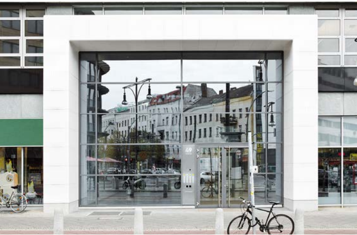
Durante el día, la tecnología de iluminación aparece oculta y protegida por una superficie uniforme de HIMACS.
