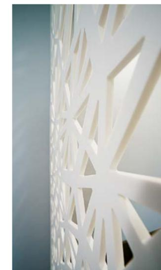
Il motivo lavorato in modo esclusivo è stato ottenuto con una fresatrice CNC ad alta precisione e utensili per falegnameria.
