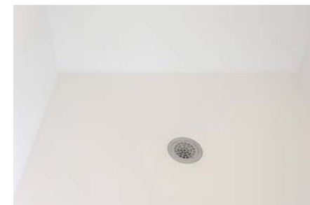
Este cómodo baño está realizado completamente en HIMACS, convirtiéndolo en una zona higiénica y de fácil mantenimiento.
